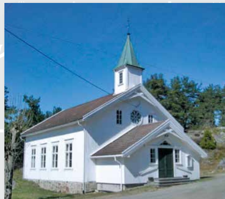
Justøy kapell Brekkestøveien, 4780 Brekkestø
